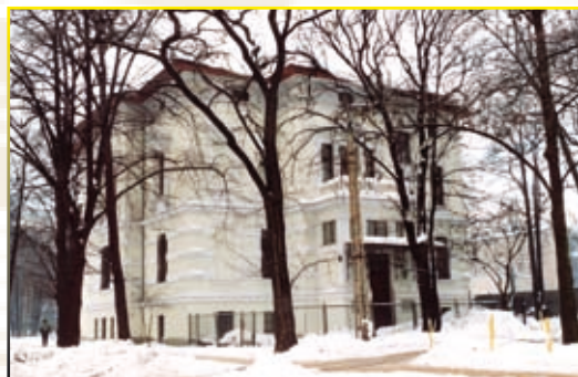
Elewacja wschodnia siedziby OIL fot. Mateusz Poradecki
